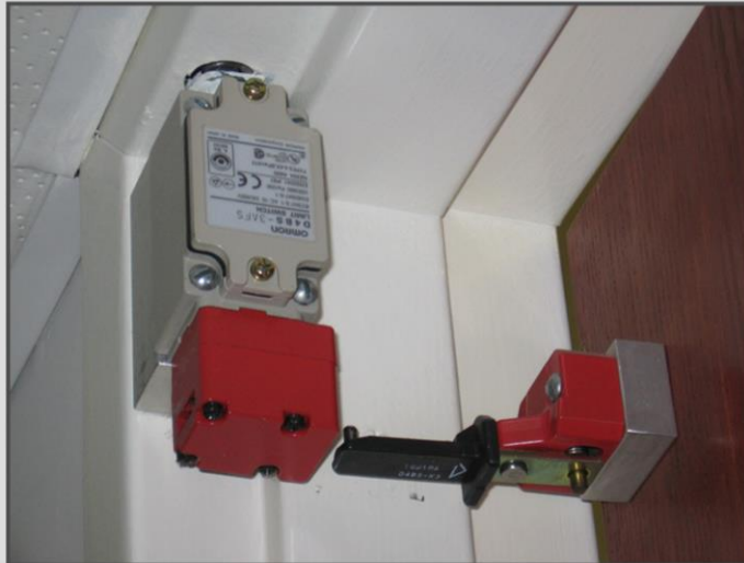
LABORATORY DOOR INTERLOCK
